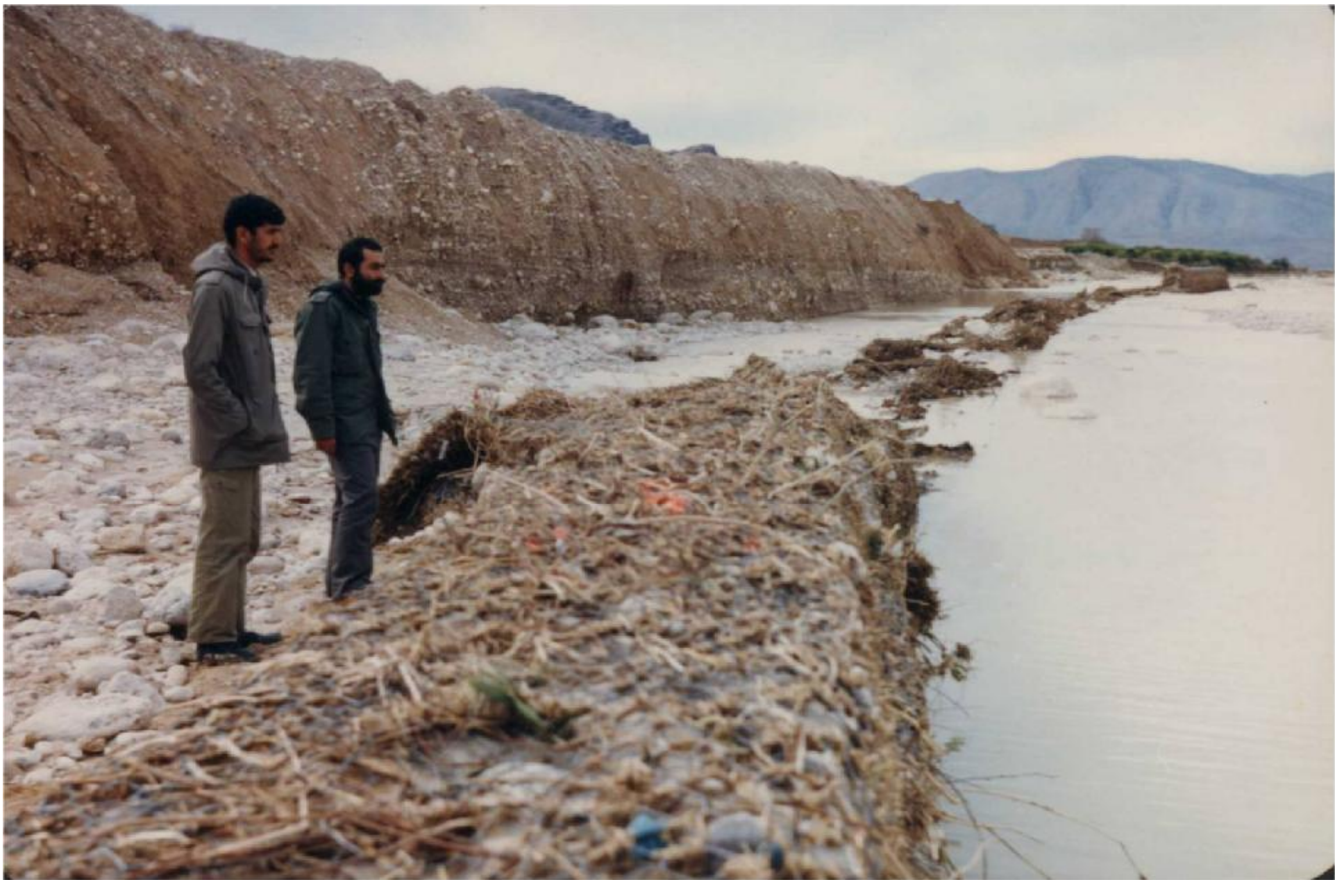
تخریب دیواره تورسنگ رودخانه فہلیان (سیل آذر 1365)
